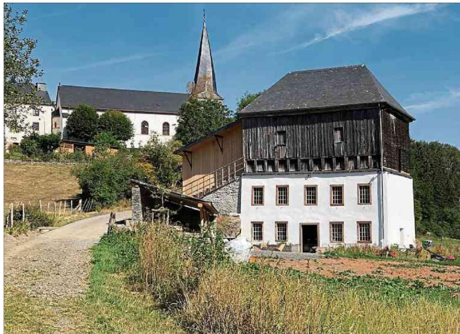
Im „Küschpelt“ hat ein mittelständiger Unternehmer die alte Gerberei restauriert und somit Denkmal- und Landschaftschutz auf glückvolle Manier miteinander verbunden. Foto: André Bauler
